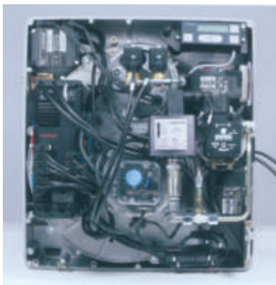
Ilustracija 3 Pregledan i pristupačan raspored svih sklopova plamenika
